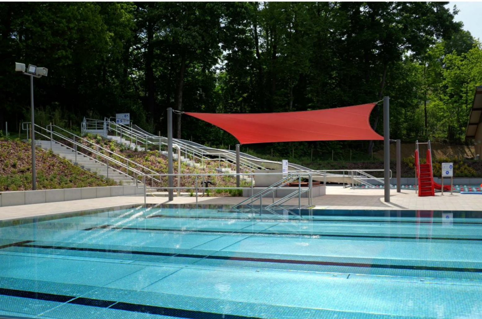
Der Wasserspiegel wurde angehoben, um die bestehende Betonplatte als Basis nutzen zu können.
