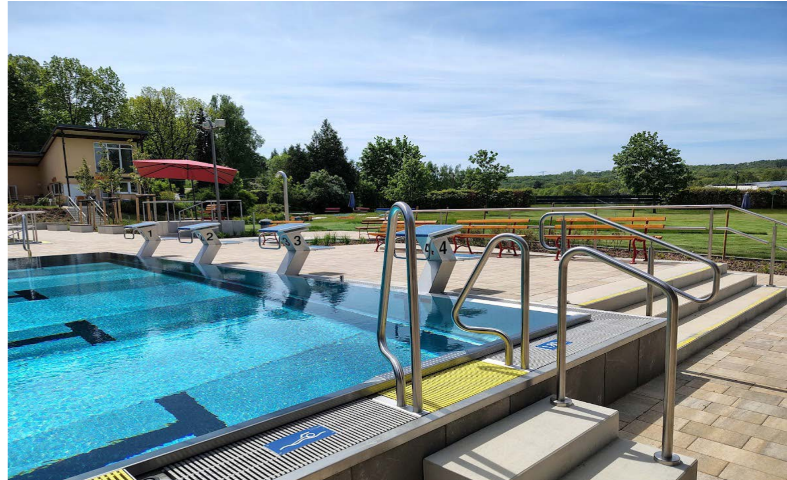
Die Beckenumgänge wurden durch verschiedene Neuanlagen und Einstiege an das erhöhte Beckenniveau angepasst.
