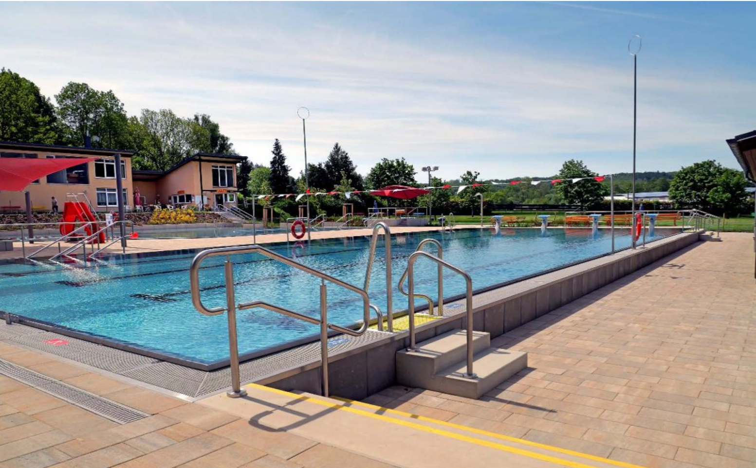
Der Wasserspiegel wurde angehoben, um die bestehende Betonplatte als Basis nutzen zu können.
