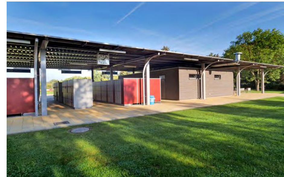
FREIBAD MÜHLHAUSEN Neubau
